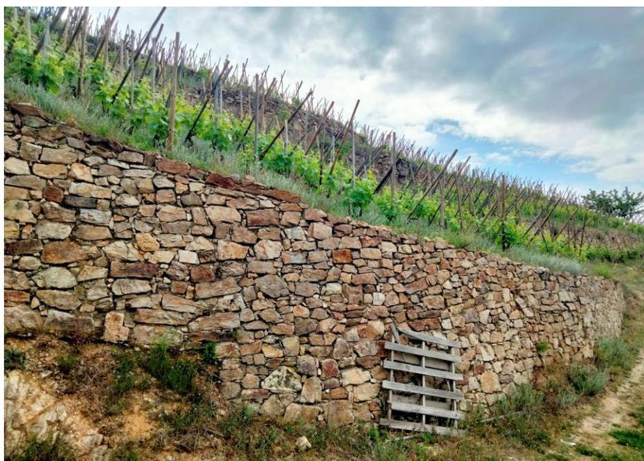
*Figure 51 : Mur en pierre érigé pour assurer le maintien de terrains viticoles sur les coteaux rhodaniens – Photo prise en visite de terrain le 6 mai 2022*
