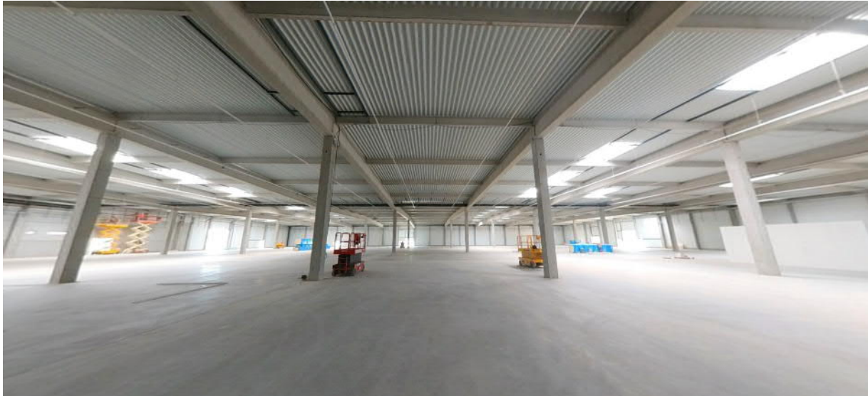
FIGURE 2.5 – Bâtiment de production ANVIS en travaux (19/07/2022)
