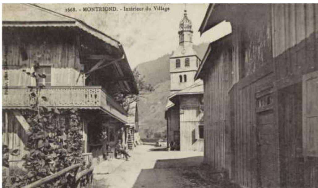
Figure 10 : Vue sur une rue menant à l'église de Montriond 24
