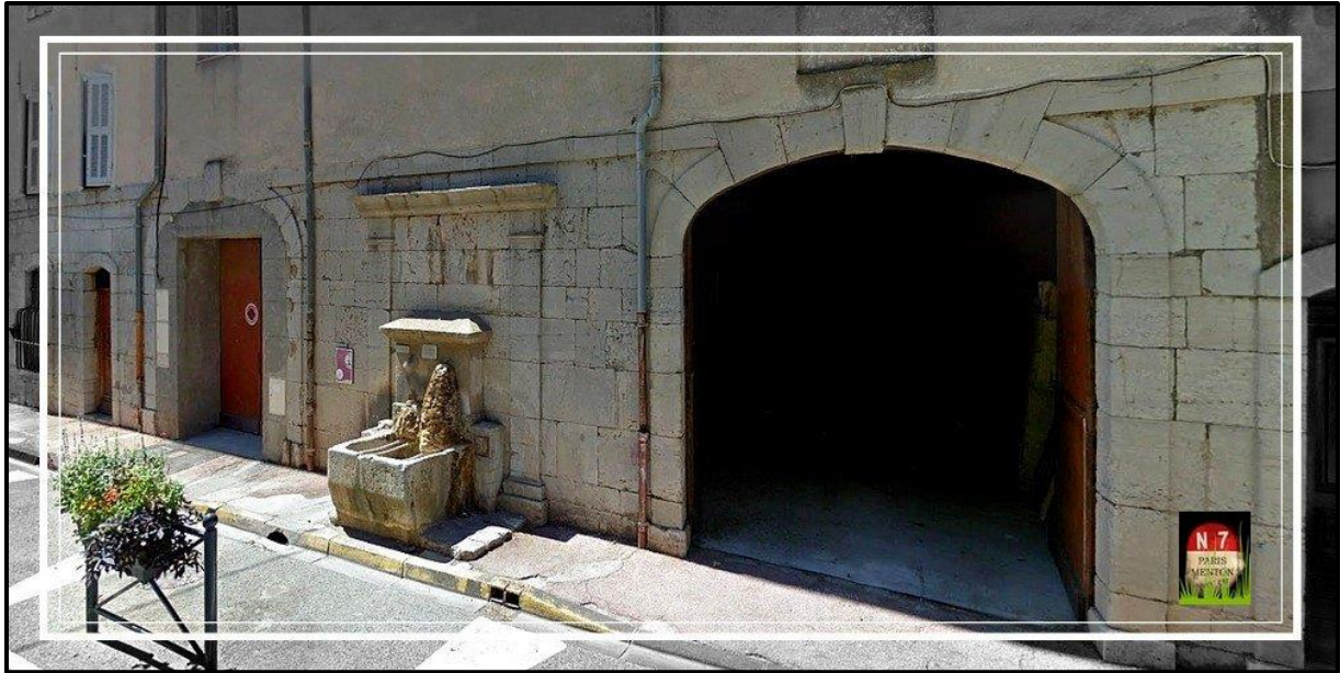
Figure 28: Les portes cochères de l'ancien relais de poste de Tourves
