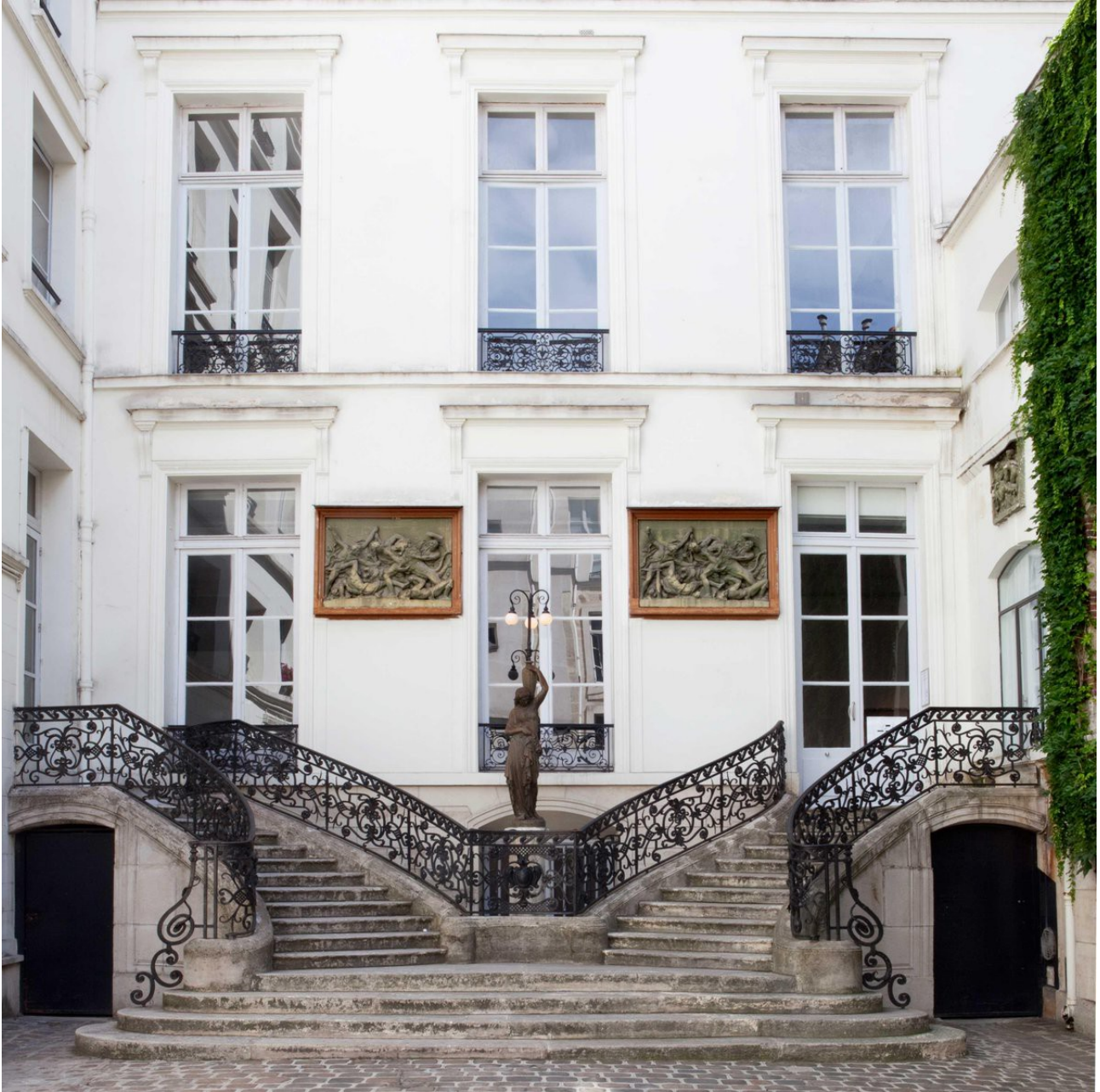
Façade du 76 rue de Turenne
