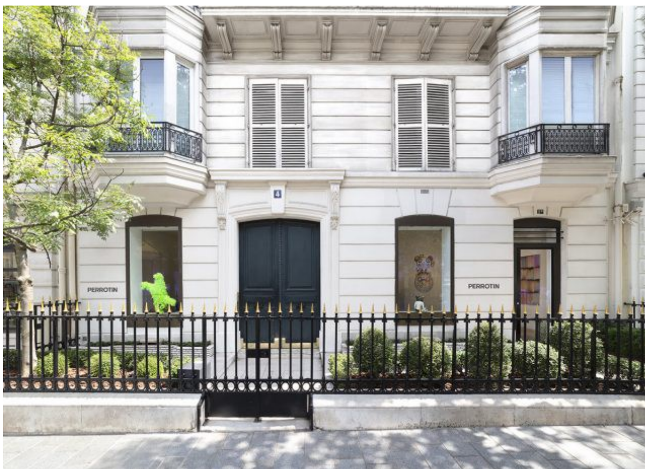
Façade du 2bis Avenue Matignon
