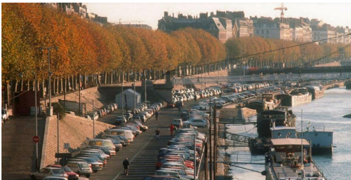
Figure 19: Les berges du Rhône en l'an 2000, un parking géant Source : Grand Lyon
