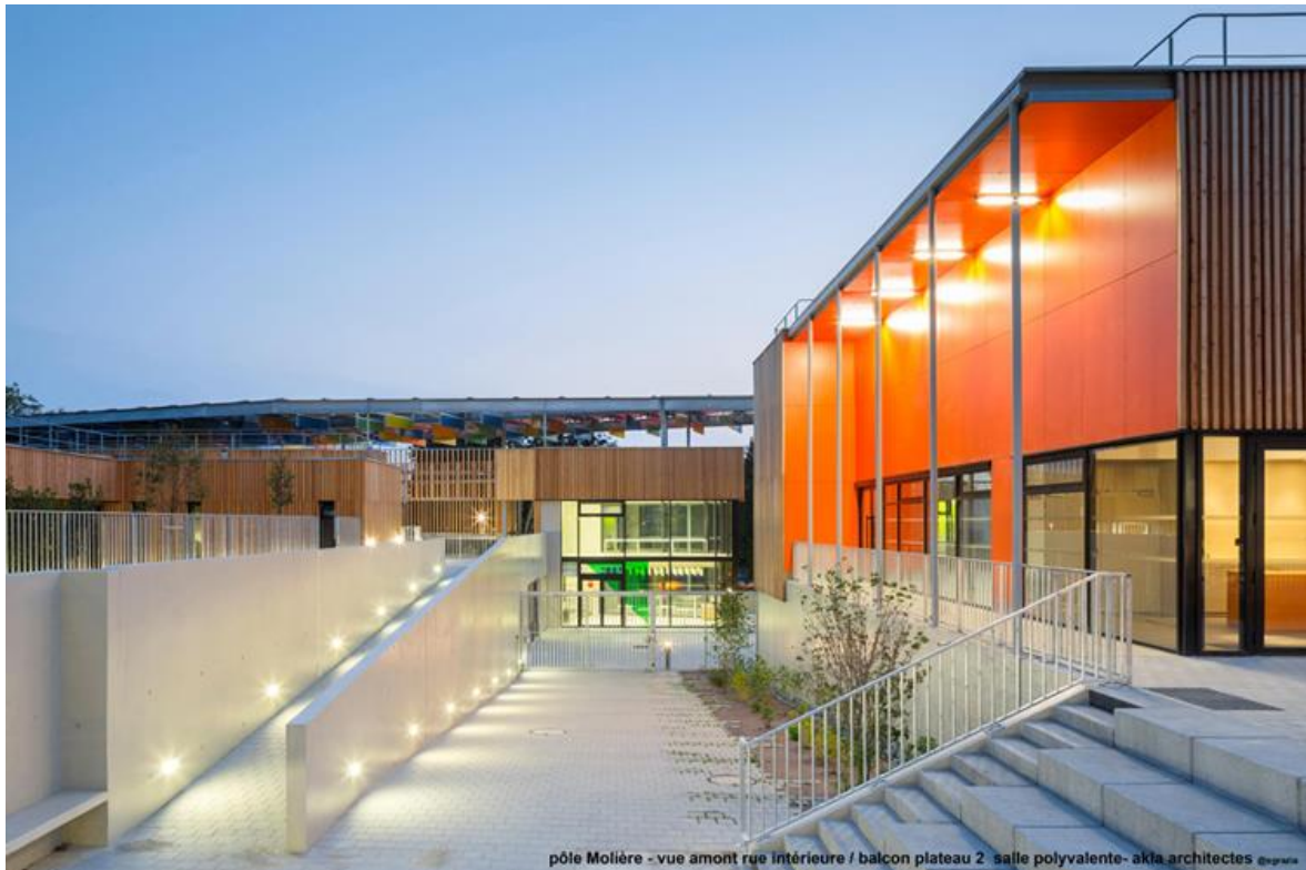
pôle Molière - vue amont rue intérieure / balcon plateau 2 - salle polyvalente- akla architectes @gratix
