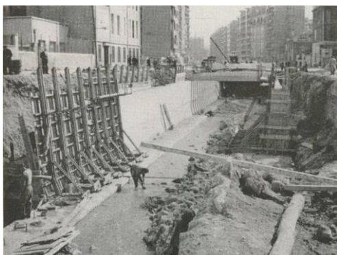
Fig. 8 : Travaux de couverture du Jarret (Source : Facebook Vieux Marseille ; 2017)
