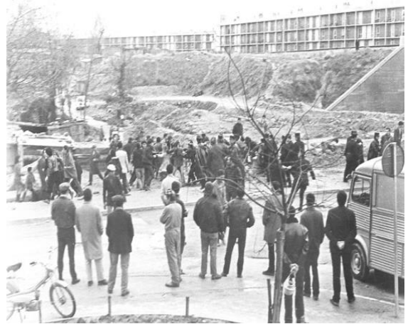
Photographie 2 : Construction des bâtiments de la ZUP n°1, 1964
