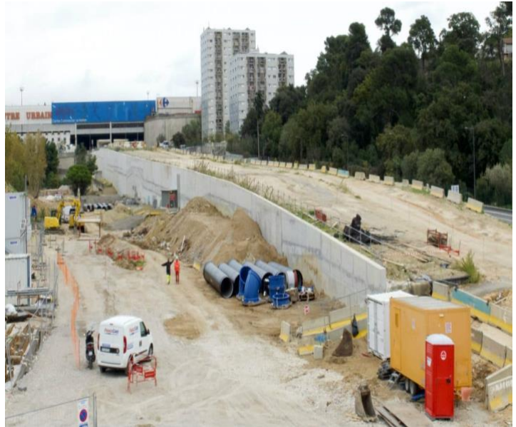
Photographie 6 : Travaux d'aménagements de la L2
