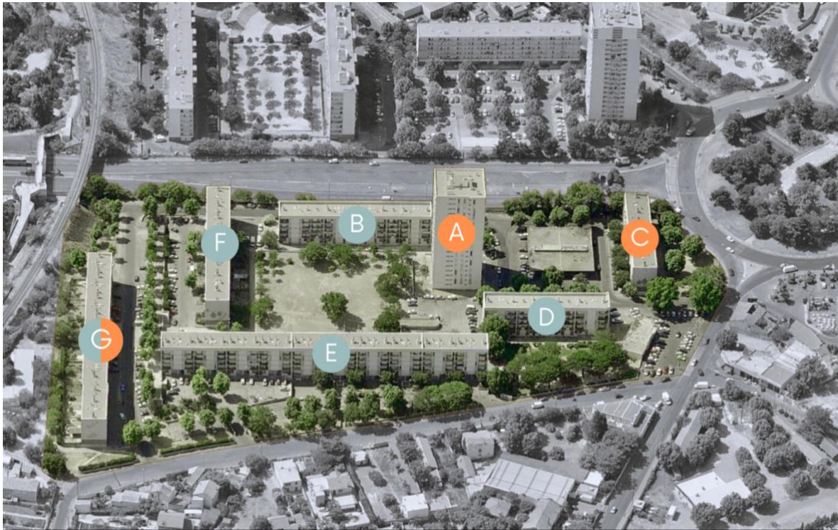
Photographie 7 : Bâtiments visés par des opérations sur Picon avant aménagements
