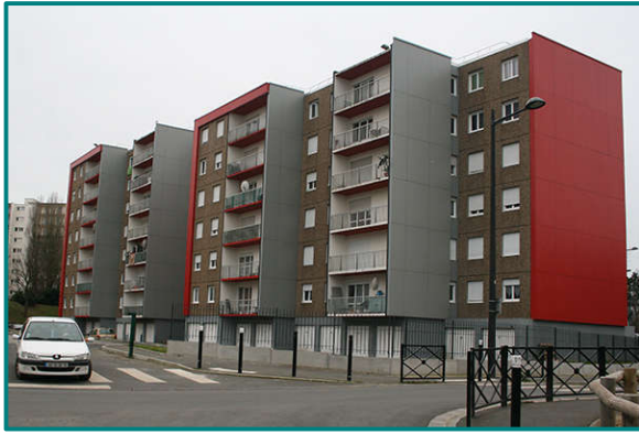
Photogr. 11 : Les immeubles du pôle Pauline Kergomard ⑦, mars 2012, A. Dubreuil
