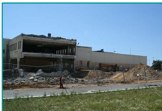
Photogr. 28 : Travaux, bâtiment du centre commercial Auchan, juin 2012, A. Dubreuil
