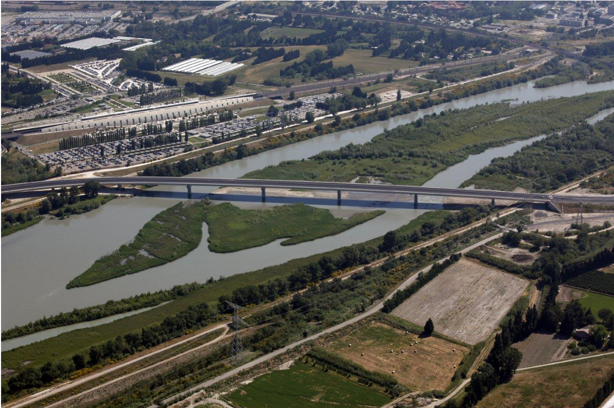
Figuré 52 : Pont de Rognonas qui permet l'accès à la gare TGV
