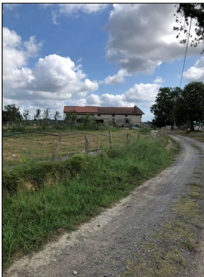
La maison Amestoya vue depuis son chemin privé 41
