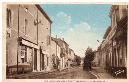
LES PENNES-MIRABEAU (B.-du-R.) — Le Centre
