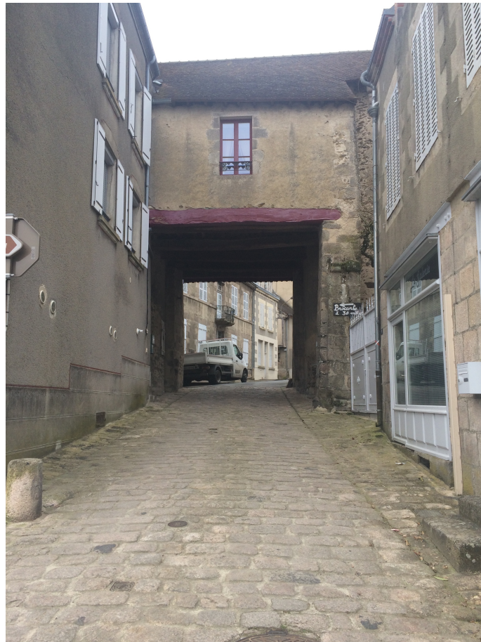
Cliché 2 : Boussac, « Rue du Docteur Gaumet », angle Nord-Est, vue depuis l'extérieur du centre ancien, Etienne Ménager, 2017
