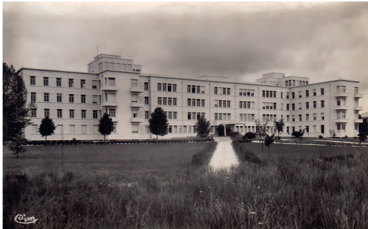
Photo de la façade sud de l'hôpital maritime Calmette
