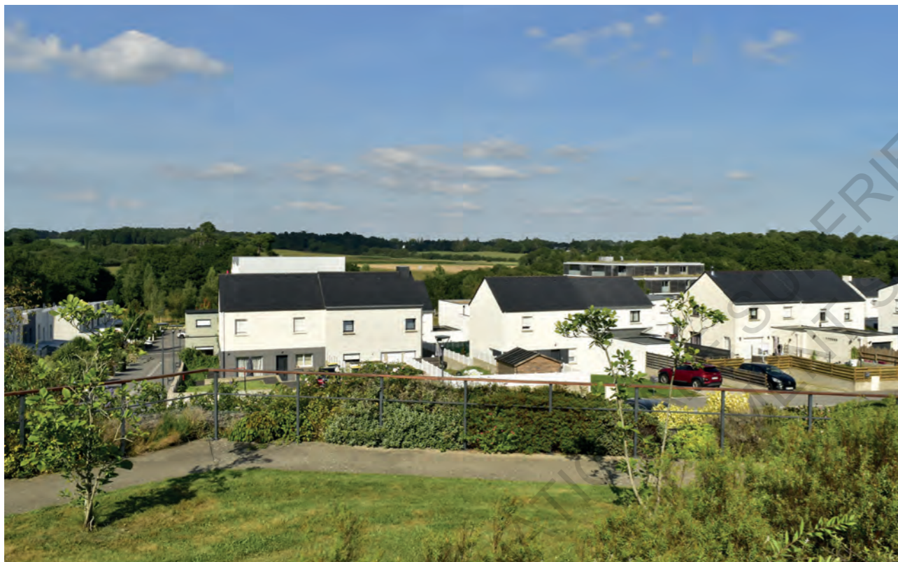
Avec les champs en arrière plan, les maisons individuelles mitoyennes et de petits collectifs d'habitation cohabitent dans une nature paysagée.
