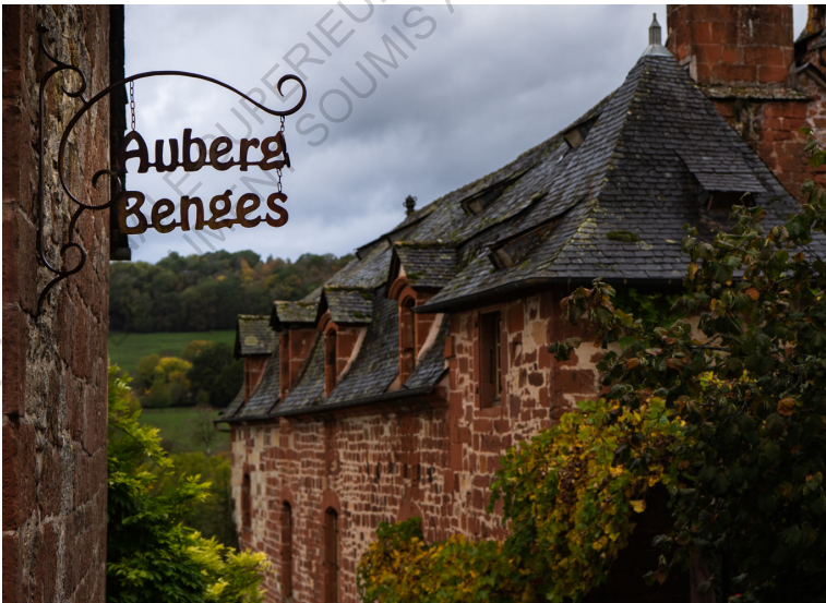
Vue sur une rue à Collonges-la-Rouge Figure 4 - Photographie du village de Collonges-la-Rouge, 2020, Corrèze.
