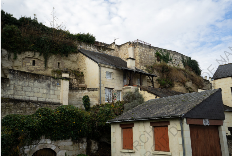
Figure 55, Photographie de la façade principale du troglo de la Chaumine, Souzay-Champigny, 2021.
