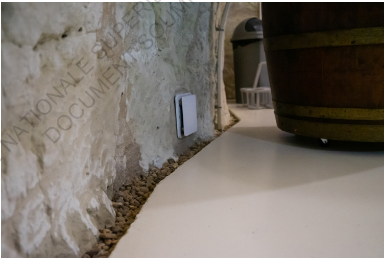
Figure 68, Photographie du drainage en bord de mur, Souzay-Champigny, 2021.
