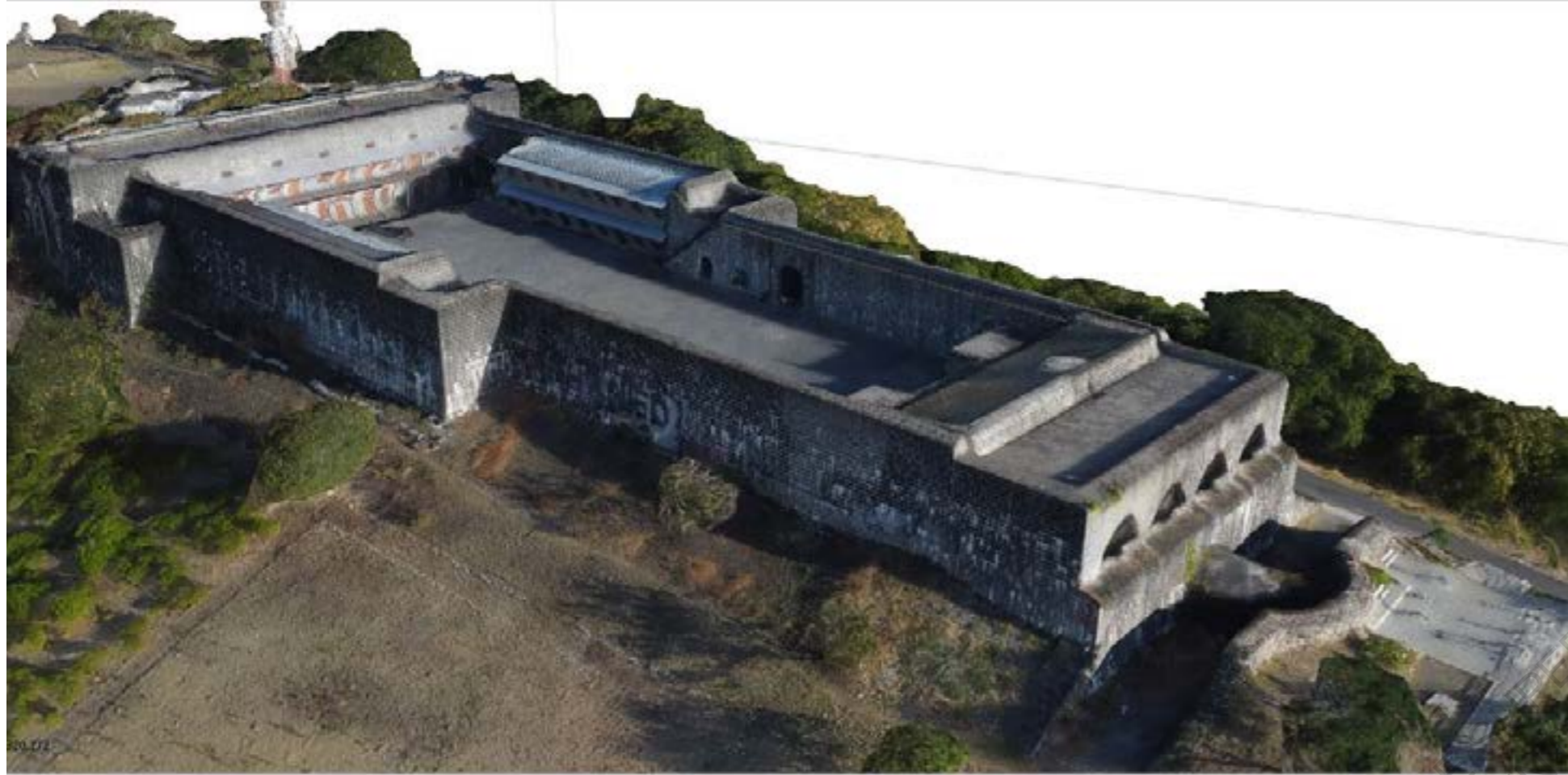
Modélisation texturé de la Citadelle de Port Louis Logiciel utilisé, Métashape Agisoft
