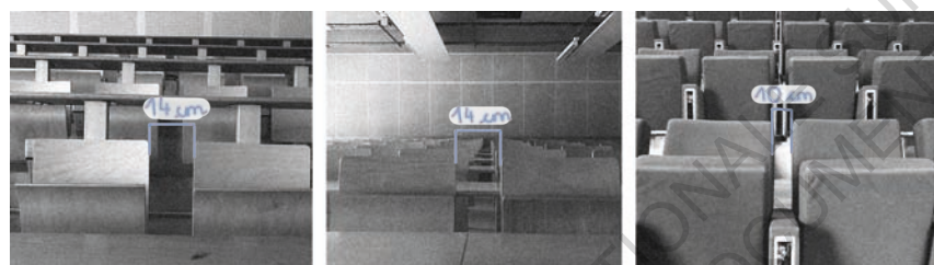
Mesures des écarts entre les sièges de l'amphi 150, de l'amphi 150bis et de l'auditorium
