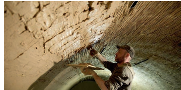
Enduit de la paille par de la terre crue ,cave de l'œuf ©atelierzerocarbone
