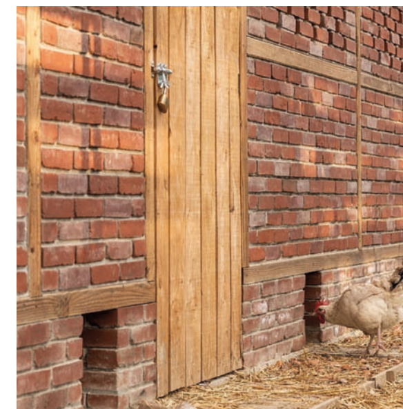
Fig 43. Les Briques Habitées
