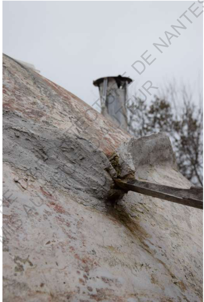
fig. 27, 28, 29 : Détail des évacuations et récupération d'eau sur les kerterres. Enduit de finition qui créé des gouttières décoratives. Photographies personnelles, 2 décembre 2022.
