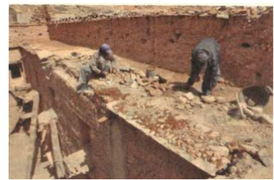
fig. 62 et 63 : Restauration du grenier d'Ait Kin. Dans Naji, Salima. Architecture du bien commun . Metispresses. Vues D'ensembles. Genève, 2019.
