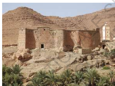
fig. 44 : Grenier fortifié d'Adkhs avec ses formes courbes.
