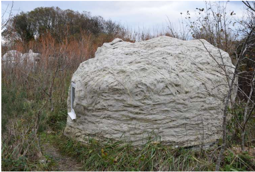
fig. 33 : Construction primaire de la kerterre, avant l'enduit. Filaments de chanvre mélangé dans chaux hydraulique, eau et sable visible. Photographie personnelle, 2 décembre 2022.
