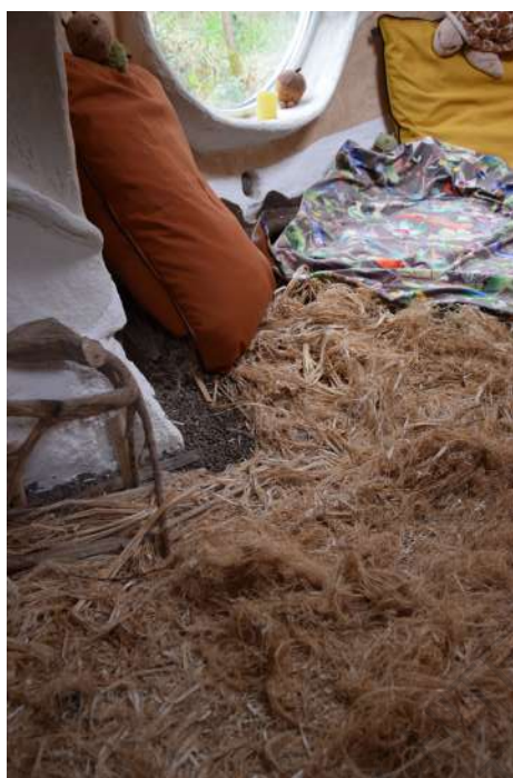
fig. 25 et 26 : Sol d'une kerterre, tapis de chanvre sur billes d'argiles. Et détails de la porte en bois et des gouttières. Photographies personnelles, 2 décembre 2022.
