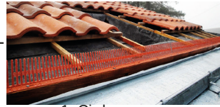
1. Ci-dessus une photographie de pare moineau, objet servant à prévenir la nidification d'oiseaux sur les tuiles sablières. (source image : groupe OBP, https://www.opb-group.fr/fr/metiers_toiture.html ).
