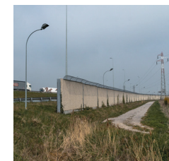
AU PIED DU MUR «Le mur de Calais» : 4 mètres de haut, 1 kilomètre de longueur le long de la N216 menant au port de Calais : 2,7 millions d'euros.
