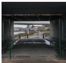
NO PASARAN Grillage installé devant une passerelle, qui empêche le passage.
