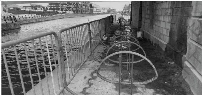
Fig. 26 : Des porte vélo sous les ponts, pas pratique - photographie : La Voix du Nord - 2021
