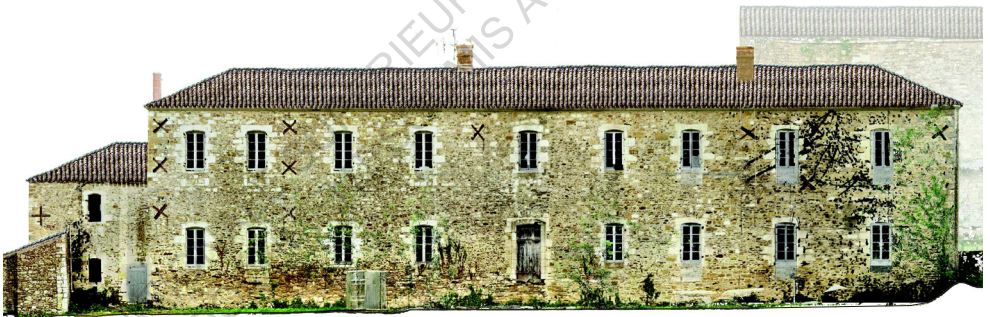
BÂTIMENT CONVENTUEL - Façade sud-ouest
