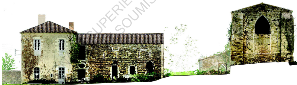
BÂTIMENT CONVENTUEL / SALLE CAPITULAIRE / EGLISE ABBATALE - Façade sud-est
