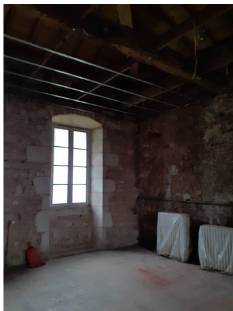
Intérieur du bâtiment conventuel - espace des gîtes
