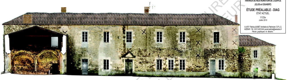
BÂTIMENT CONVENTUEL - Façade nord-est
