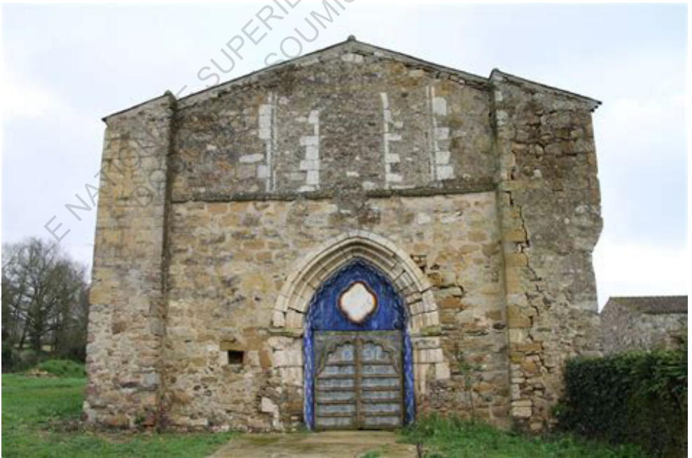
Pignon nord de l'abbatiale
