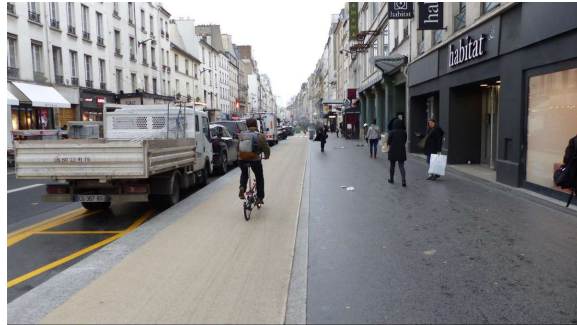
Figure 37. Piste cyclable séparée. © Cerema
