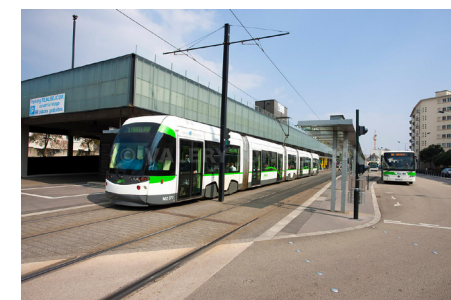
Figure 33. Beauséjour et son parking relais en hauteur : un long bloc entre les immeubles du quartier. © Valéry Jonchery
