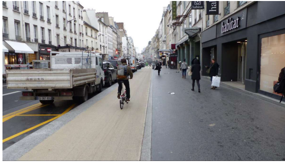
Figure 37. Piste cyclable séparée. © Cerema
