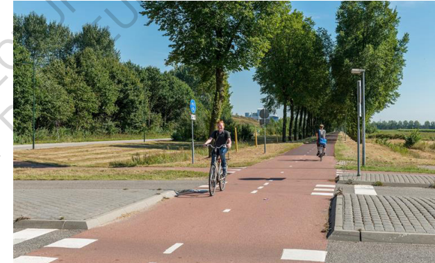
Figure 40. Amsterdam, La nouvelle frontière : les autoroutes cyclables interurbaines, 2018 © Snelle fietsroutes
