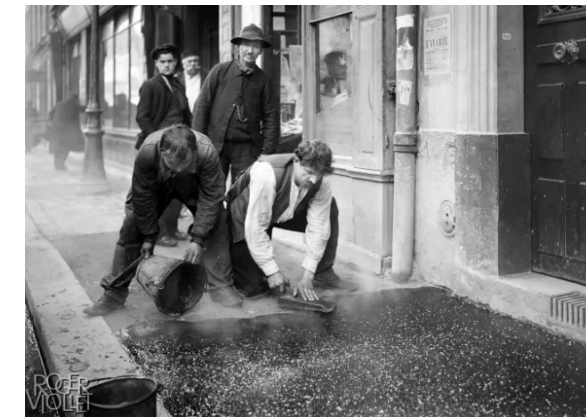
Figure 7. Etendage du bitume sur un trottoir. Paris, 1908. © Jacques Boyer / Roger-Viollet
