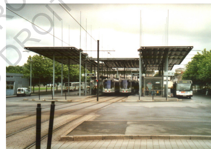
Figure 32. Arrêt de tram Pirmil © Claude Villeteuse
