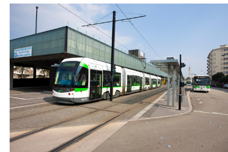
Figure 33. Beauséjour et son parking relais en hauteur : un long bloc entre les immeubles du quartier. © Valéry Jonchery
