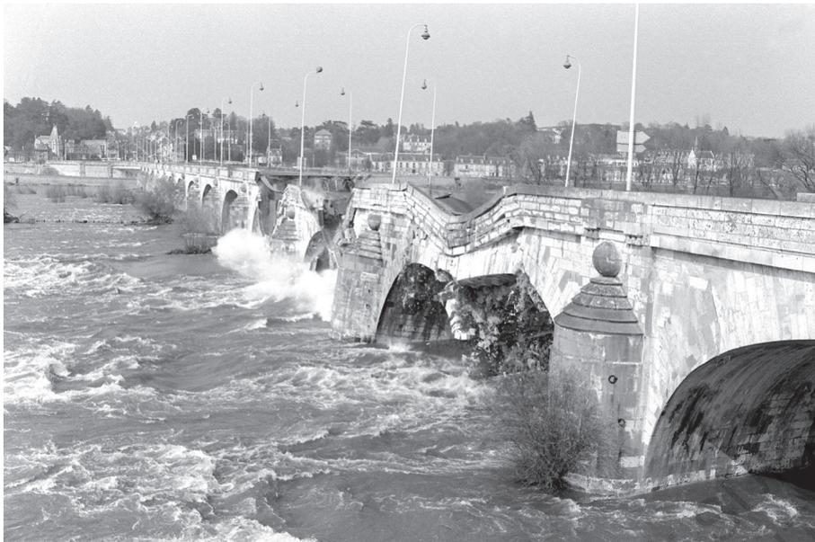
Fig. 7. Effondrement du Pont Wilson à Tours
