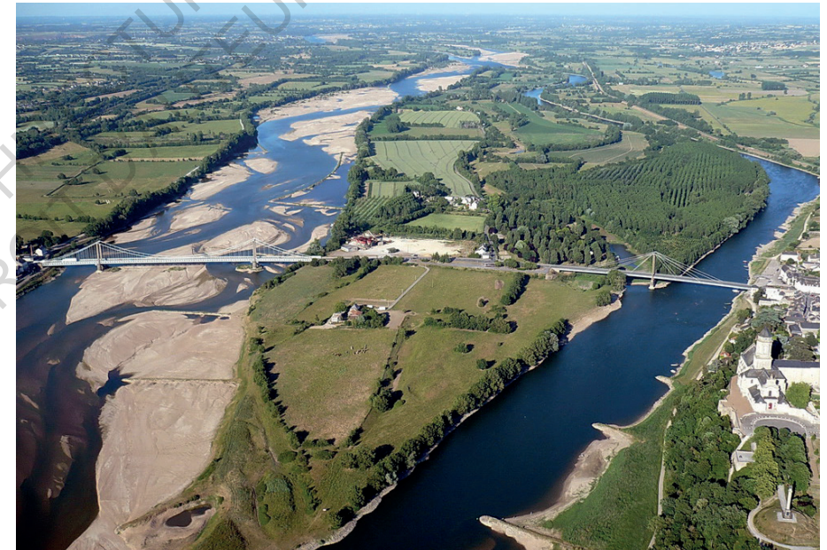
Fig. 37. Vue aérienne des deux ponts de l'île Batailleuse
