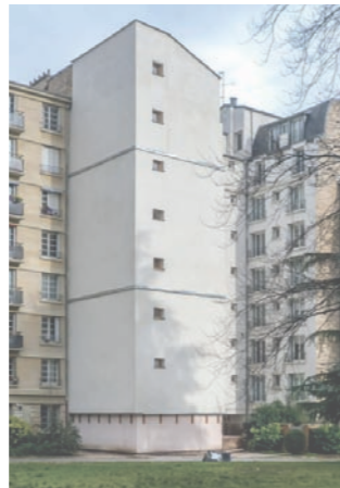
▲ Rénovation thermique en isolation par extérieur en paille, d'un immeuble des années 1920 (géré par le bailleur social Paris Habitat) 132 rue de la convention, Paris. Collect'IF Paille, agences d'architecture Landfabrik et Trait Vivant. Source : Landfabrik.fr
