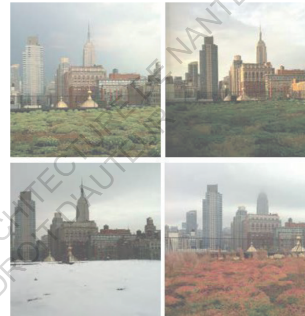
Le toit végétalisé des bureaux des Architectes COOKFOX à New York qui évolue au long de l'année, connectant les occupants visuellement avec les saisons.
