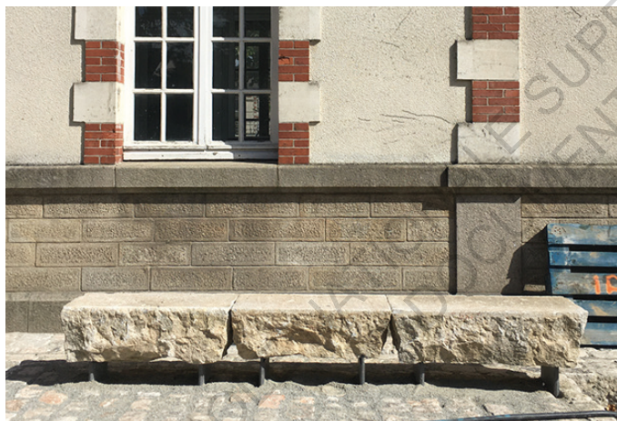
Fig 41 : Banc composé des pierres réemployés, bois et acier, Atelier Georges.
