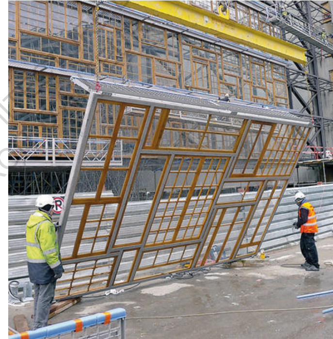
Fig 28 : Chantier du siège du Conseil européen à Bruxelles.
