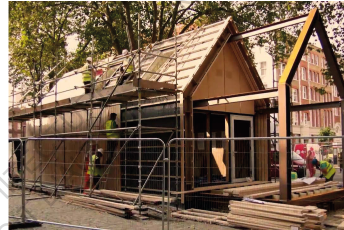
Construction de l'enveloppe avec des solives/lattages en bois.
