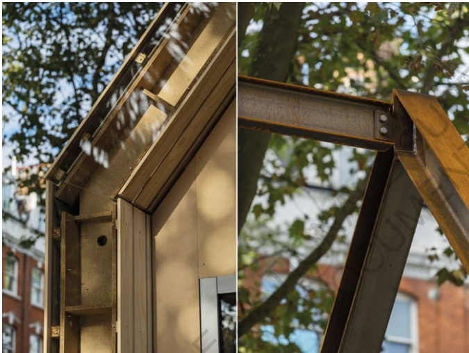
Des assemblages apparents démontrant la possibilité d'extension.
