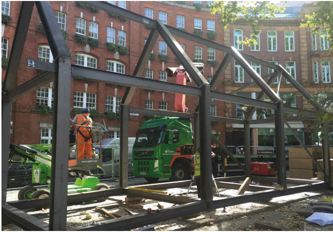
Construction de la structure avec des éléments préfabriqués.
