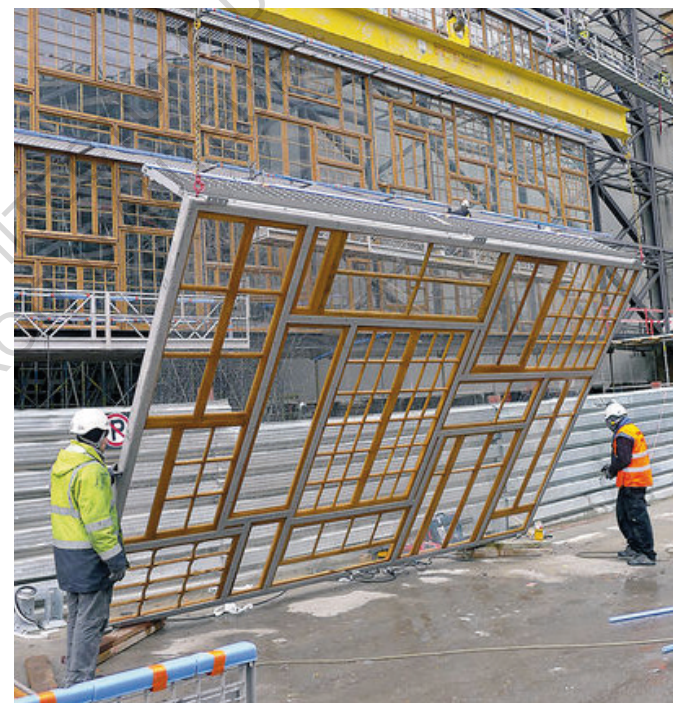
Fig 28 : Chantier du siège du Conseil européen à Bruxelles.
