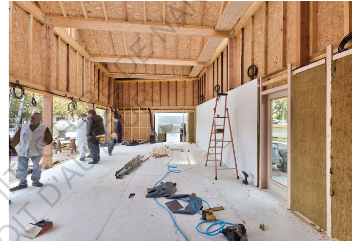
Construction de l'intérieur avec des panneaux d'exposition.
