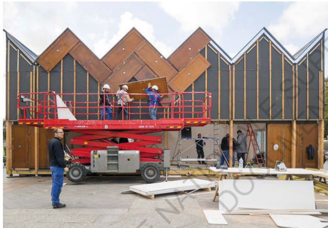
Façade constituée de portes en chêne provenant d'immeubles HBM.
