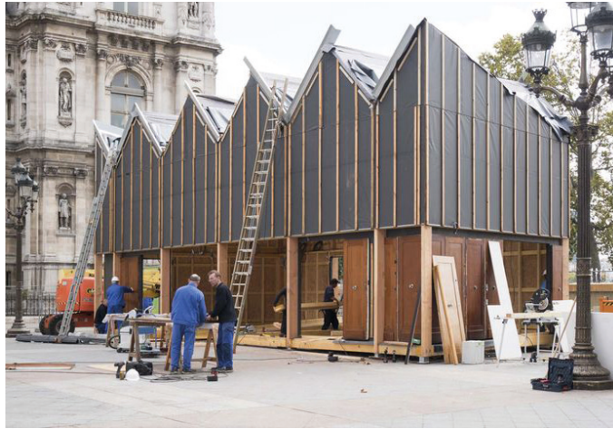
Construction de l'enveloppe et ajustement des éléments sur le site.
