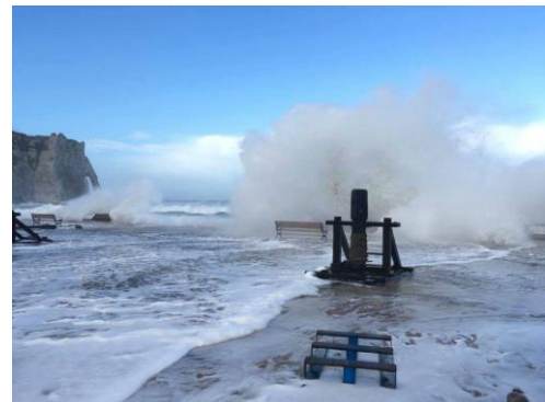
Figure n°33 : Franchissement des vagues sur la digue, Morgan L.L. en 2016
