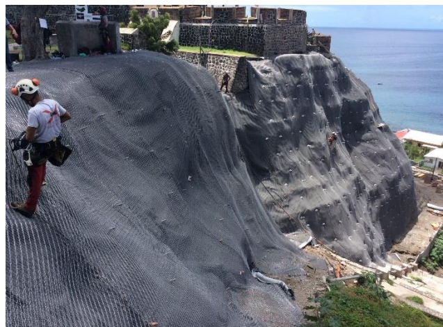
Figure n°42 : Exemple d'infrastructures de renfort de falaises, Auteur inconnu, 2019
