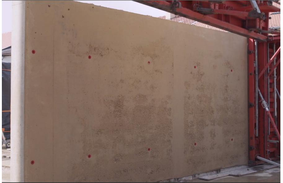
Béton de terre coulée : décoffrage du mur.
