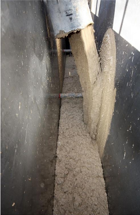
Béton de terre coulée : remplissage des coffrages.
