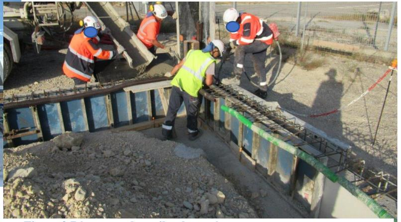
Figure 9 Bétonnage des voiles de soutènement
