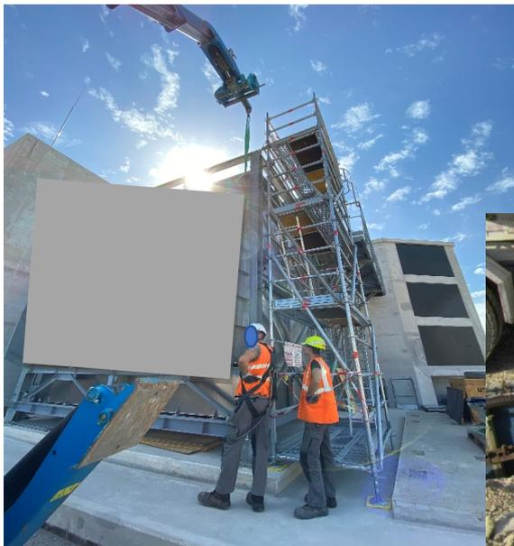
Figure 8 Montage d'un aéro-réfrigérant
