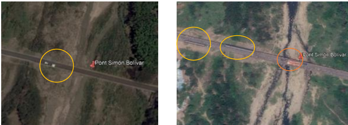
Figure 8. Vue satellite du pont en octobre 2015 et mars 2020
