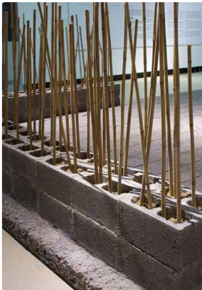
Figure 77 : Présentation des Rebirth Brick. Remplissage structurel en bambou. Liu Jiakun. Biennale d'architecture Hong-Kong. (2011).
