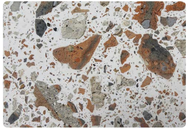
Figure 66 : Expérimentations béton de plâtre. CIGUË.
