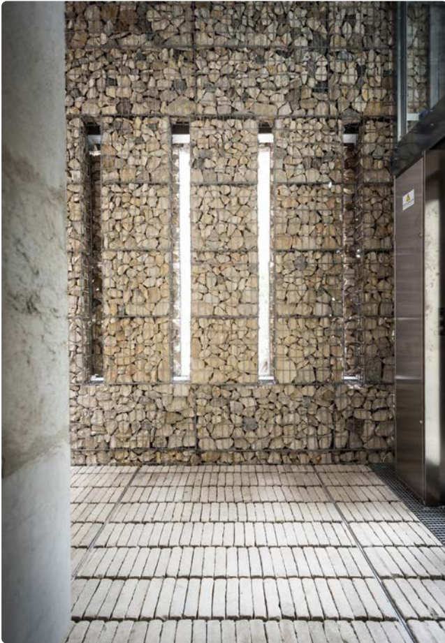
Figure 69 : Projet du fort l'Écluse. atelierpng, Léaz. (2016-2019).
