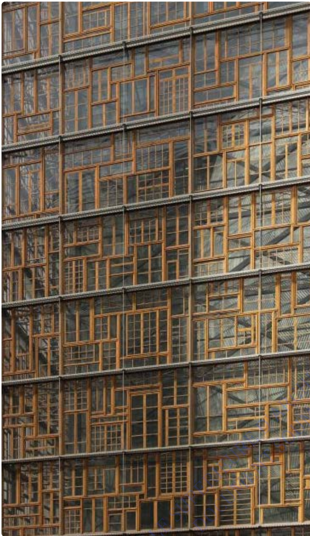
Figure 43 : Façade réemploi du Siège du Conseil européen, Bruxelles. (2016). Architecte : Philippe Samyn.
