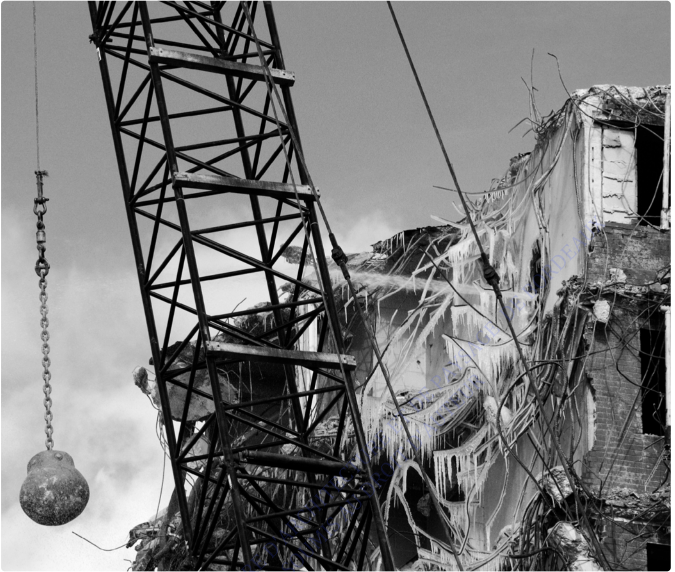
Figure 41 : Chantier de démolition. Chicago, Illinois. (2006). Paul Goyette.
