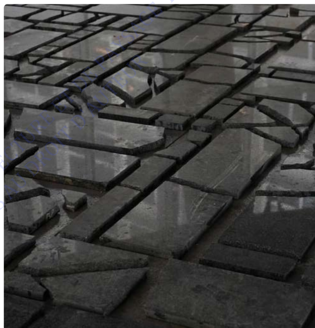
Figure 72 : Calepinage et morceaux de granite en place avant coulage. (2021). Anna St-Pierre.
