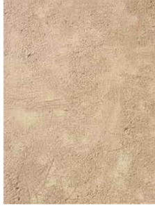
Finition extérieure Enduit à la chaux
