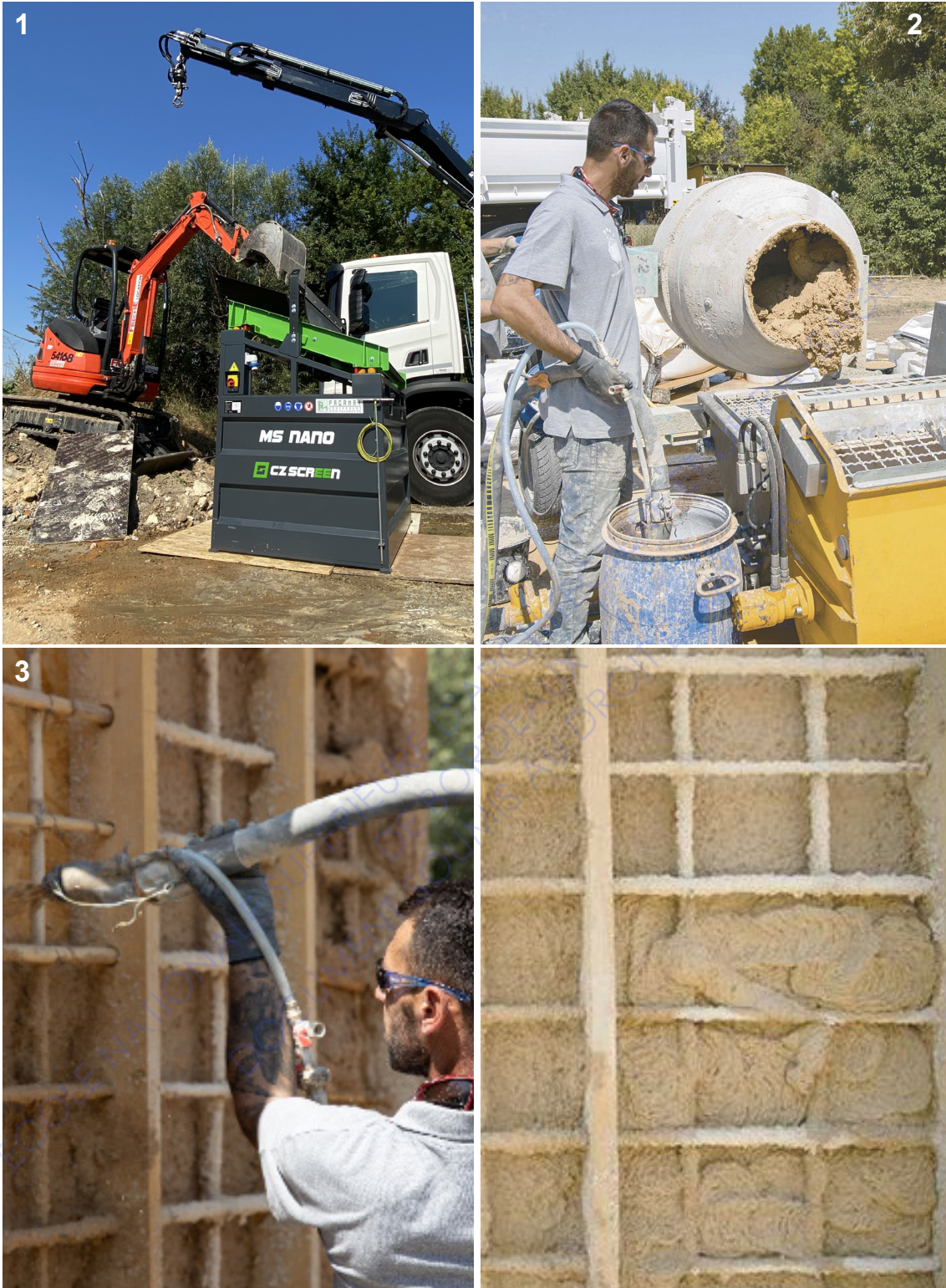
Fig 50, photographies de la mise en œuvre de la solution terre St Gobain/Norper. https://www.lemoniteur.fr/article/la-terre-crue-se-projette-dans-l-avenir.2103304
