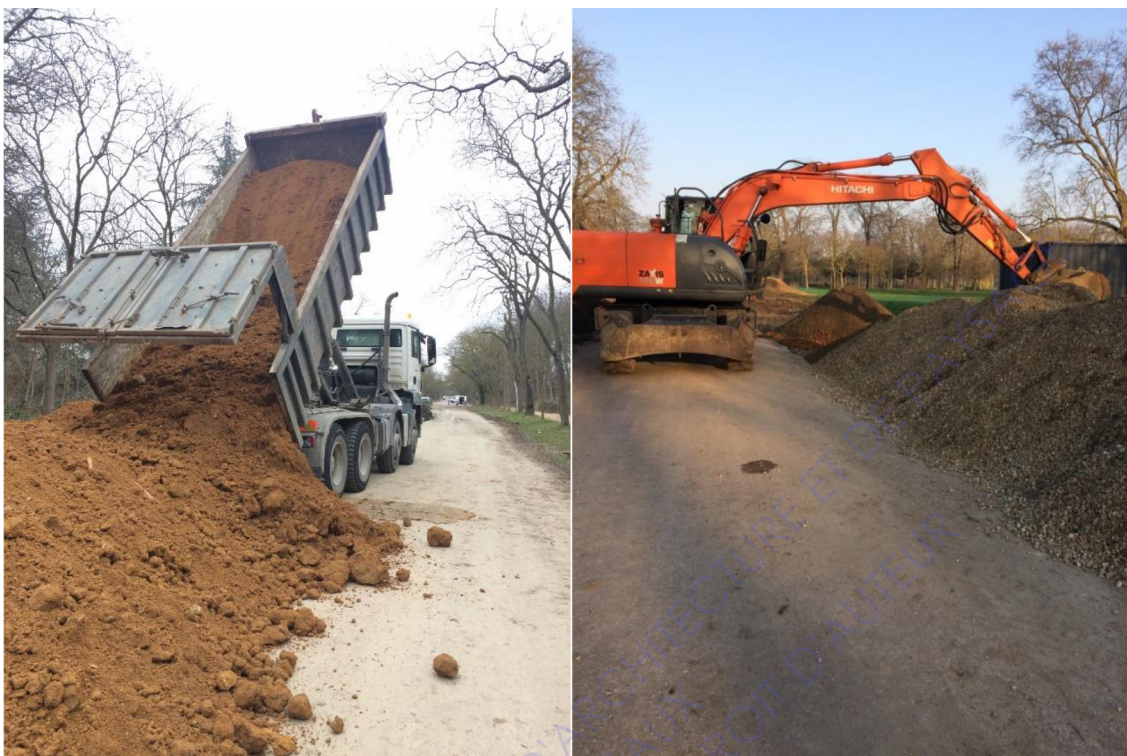
Fig 55, Photographies des réceptions des terres excavées issues de chantier et un tractopelle mélangeant les matériaux pour les fosses d'arbres. Source : Charlotte Pruvost.
