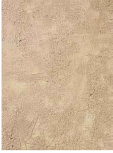
Finition extérieure Enduit à la chaux
