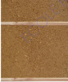
Finition intérieure terre + ossature bois
