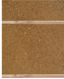
Finition intérieure terre + ossature bois
