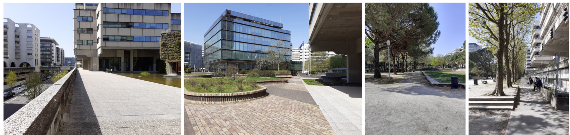
Figure 124 : Revêtements de sols et façades- Terrasse de l'esplanade Charles de Gaulle - Mériadeck - Bordeaux (auteure)
