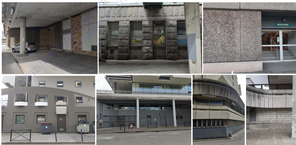
Figure 110: Niveau Rue du quartier Mériadeck – des façades opaques (auteur)
