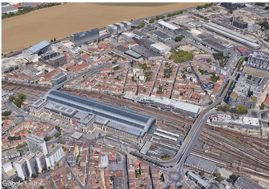
Figure 67: Vue aérienne de la Gare Saint-Jean Bordeaux et de son environnement proche (Google Earth)
