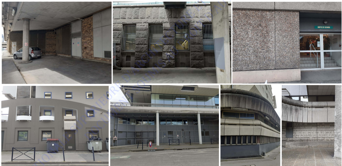
Figure 123 : Revêtements de sols et façades des bâtiments - Rez-de-rue - Mériadeck - Bordeaux (auteure)
