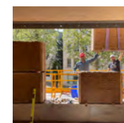
TERRIO 02.05.2023 Pisé préfabriqué à Boulogne-Billancourt Façades en pisé sur un chantier de 8 logements sociaux.
