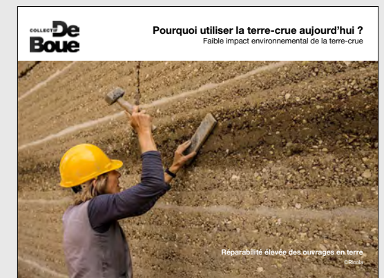
Faible impact environnemental, réparabilité et réversibilité des ouvrages en terre crue.
