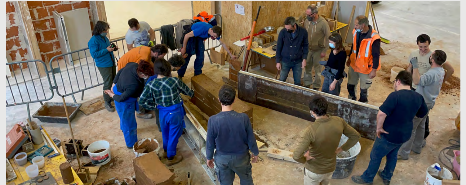
Réalisations de groupe. Le moment du décoffrage du muret en pisé est un moment important pour le groupe. Il est le résultat de plusieurs jours de formation et de quelques heures de mise en oeuvre. Les participant-e-s découvrent l'objet fini et prennent conscience de la rapidité et de l'accessibilité de l'apprentissage de cette technique de construction en terre, en quelques jours ils ont assimilés les fondamentaux et sont capables de mettre en oeuvre la terre crue.
