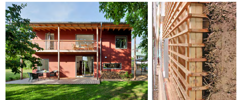
Haus J, projet de l'agence d'architecture Schauer + Volhard Architekten BDA à Darmstadt en Allemagne. Ossature bois, murs de façade en terre-allégée, isolation par l'intérieur ovate de cellulose. Crédits images Schauer+Volhard Architekten BDA
