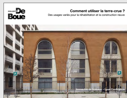
Exemple de réalisation contemporaine montrant une mise en œuvre en compression de la terre crue.
