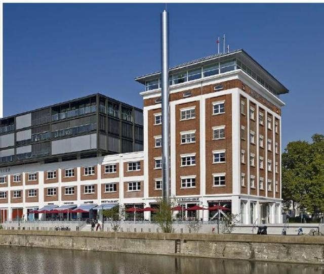
Transformation de l'ancien entrepôt Seegmüller construit en 1932 en programme immobilier mixte. La structure poteaux-poutres d'origine est en béton. Les briques de parement originelles ont été conservées ou remplacées à l'identique.
