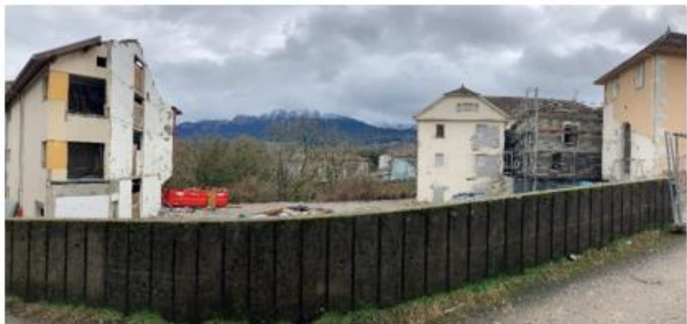
Photographie chantier en cours, source : Mathilde
