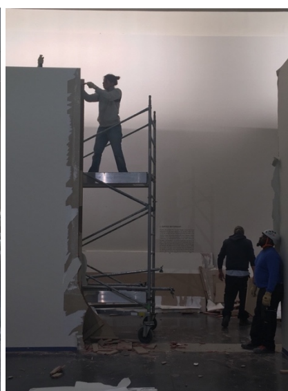
Démolition d'une cimaise.
