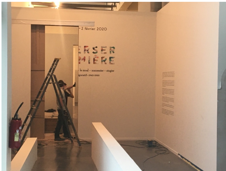
Agrandissement de la porte d'entrée pour l'exposition de Marcel Gromaire. Prestation faite par une entreprise extérieure de scénographie.
