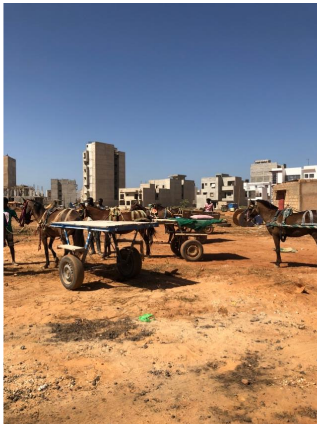
Figure 12 : Rassemblement de charretiers sur un chantier à Ngor, Dakar, Sénégal. (Source : P. Lejosne)
