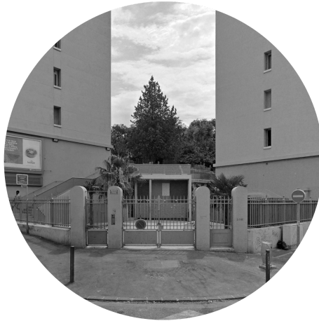
Figure 12 : Image montrant un espace ouvert clôturé
