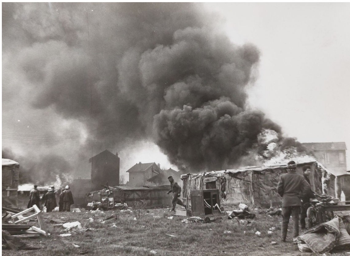
Figure 5: Opération du 15 mars 1958, Château Mirabeau, photographie jointe au rapport du commissaire du 1 er arrondissement, AD 78 1W1854
