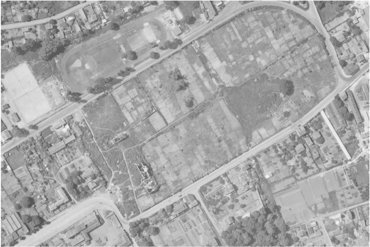
Figure 1: Photographie aérienne du Château Mirabeau en mai 1952, fonds de l'IGN (extrait)
